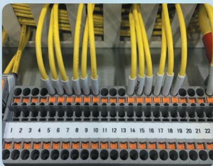
使用部品には圧着レスタイプの差し込み端子を採用し、作業性を高めています。
